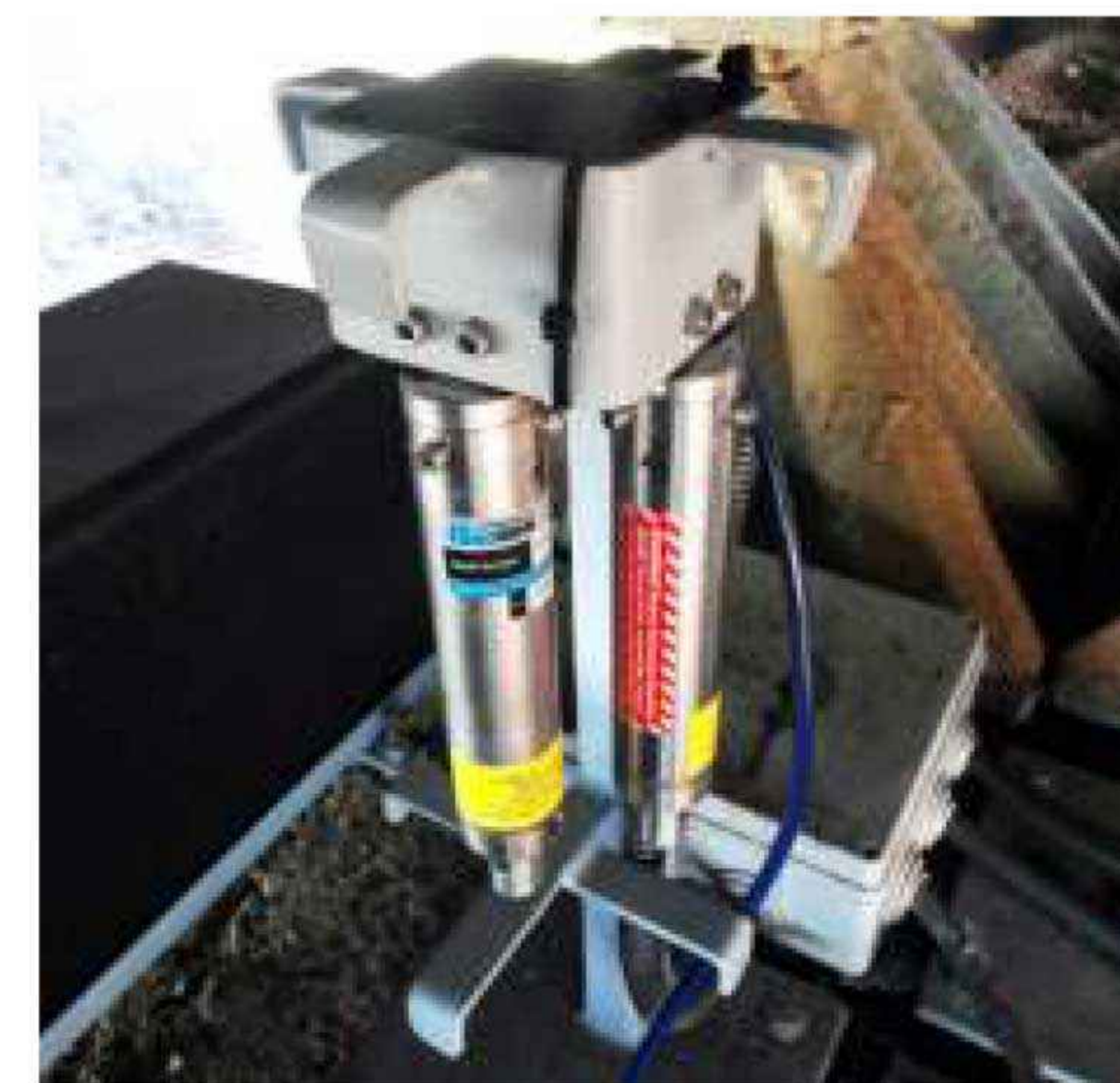
Dwukierunkowy punkt pomiaru przemieszczeń kątowych na podporze środkowej wiaduktu
