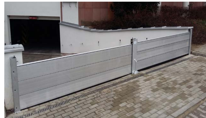
📍 Warszawa 📄 Zabezpieczenie przeciwpowodziowe budynków mieszkalnych 📏 0,4 i 0,6 m
