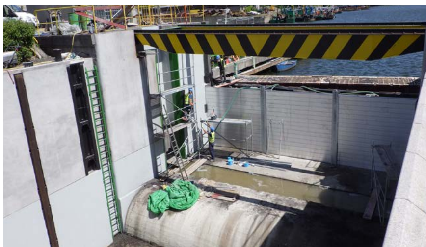
📍 Warszawa 📄 Przebudowa śluzy Żerań 📏 3,6 m
