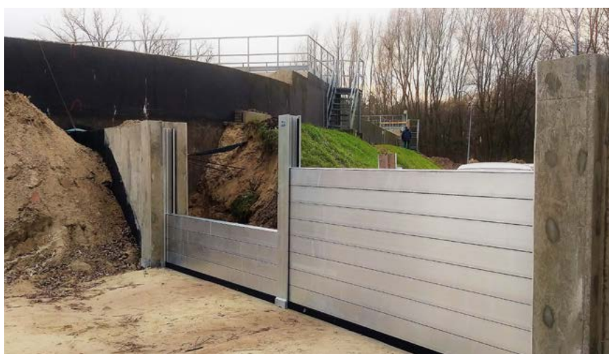
📍 Białobrzegi 📄 Mobilne zapory przeciwpowodziowe w oczyszczalni ścieków 📏 1,65 i 1 m
