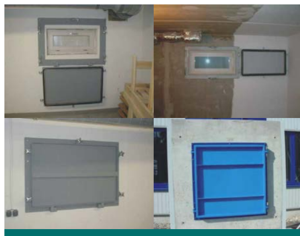
Zabezpieczenie przeciwpowodzione okien piwnicznych.
