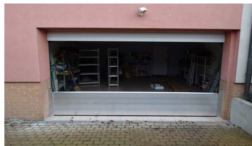
📍 Kraków Zabezpieczenie budynku mieszkalnego 📏 0,6 m
