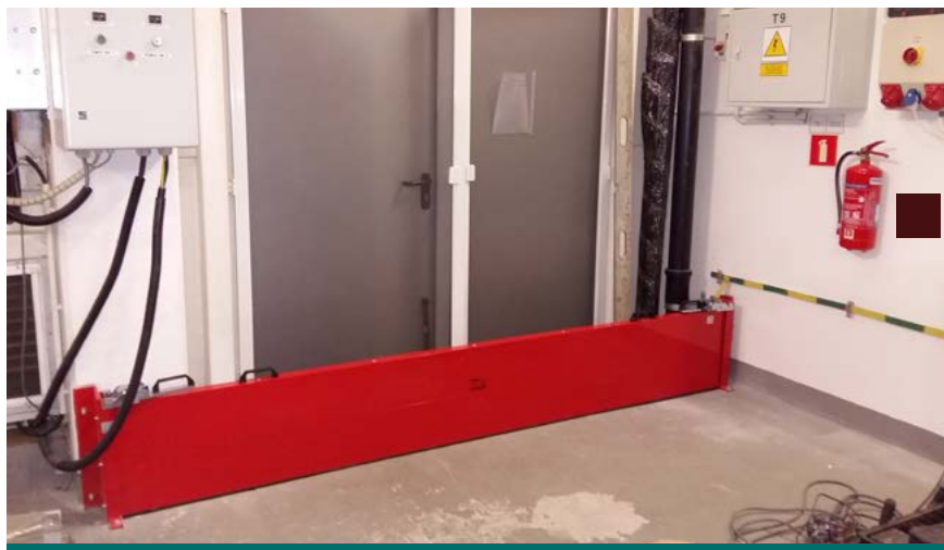
📍 Łódź 📄 Zamontowanie szczelnych barier przemysłowych 📏 0,4 m
