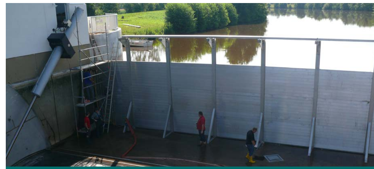
Zamknięcie remontowe śluzy.
