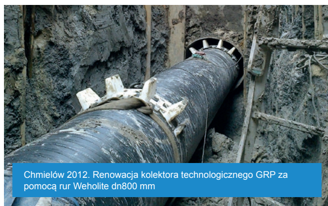
Wrocław 2008. Renowacja magistrali wodociągowej rurą specjalną PEHD d.1033 mm
