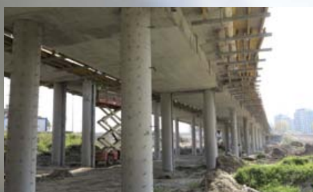
Naprawa zaprawami torkretowymi do suchego natrysku EuroCret®.
