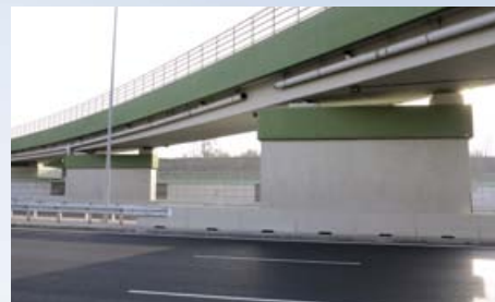
Naprawa przy pomocy systemu EuroCret®.
