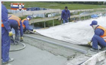
... układanie i zabezpieczenie zaprawy naprawczej EuroCret®
