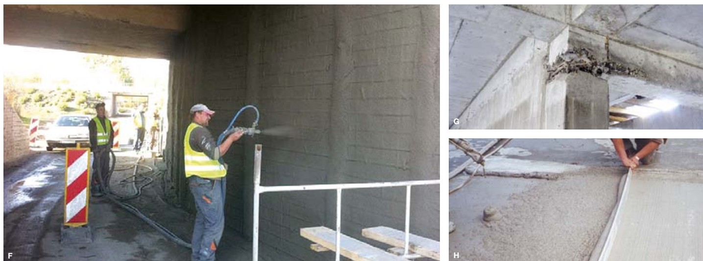
E. Komin przemysłowy przygotowywany do renowacji za pomocą EuroCret® 40 HSF | F. Podpora mostu jest powlekana EuroCret® 20 | G. Rozkute uszkodzenie podpory betonowej | H. Gradientowa niwelacja na moście z użyciem EuroCret® 40
