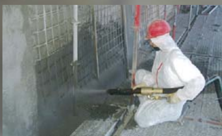
Zaprawa naprawcza EuroCret® SB 08 nanoszona metodą suchego natrysku na elementy pionowe.
