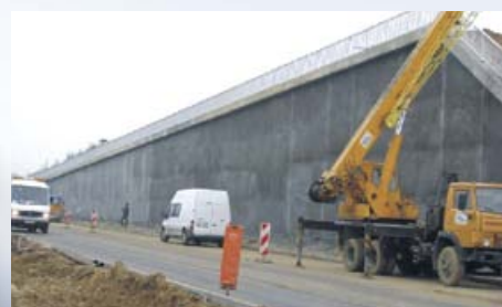
Ściana oporowa wykonana przy pomocy zapraw natryskowych EuroCret® SB 08
