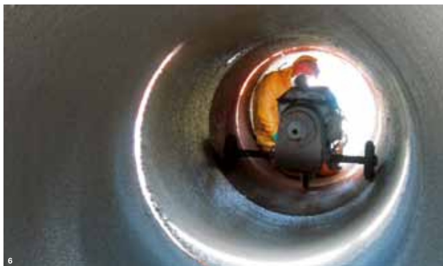
5. widok kanału | 6. urządzenie aplikujące materiał podczas pracy | 7. mała poręczna pompa natryskująca PFT | 8. substancje obce zawarte w ściekach powodujące abrazje
