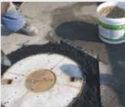
UZUPEŁNIENIE UBYTKU W POWIERZCHNI ASFALTOWEJ MATERIAŁEM TOPOLIT® BITUMENFIX
