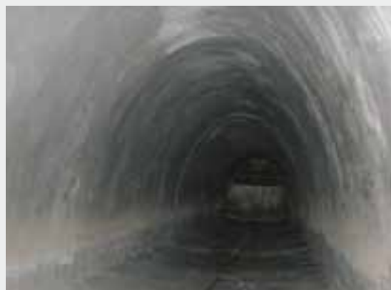
NAPRAWA I OCHRONA ŻELBETOWYCH ORAZ BETONOWYCH KANAŁÓW WYSOCE ODPORNĄ NA SIARCZANY ZAPRAWĄ TOPOLIT® KANALSANIERMÖRTEL (KSM)
