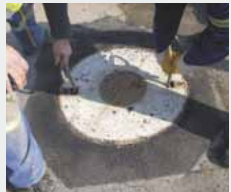
STUDNIA PO NAPRAWIE I OSADZENIU WŁAZU
