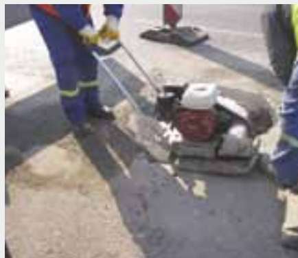
ZAGĘSZCZANIE ASFALTU NAPRAWCZEGO PRZY POMOCY PŁYTY WIBRACYJNEJ
