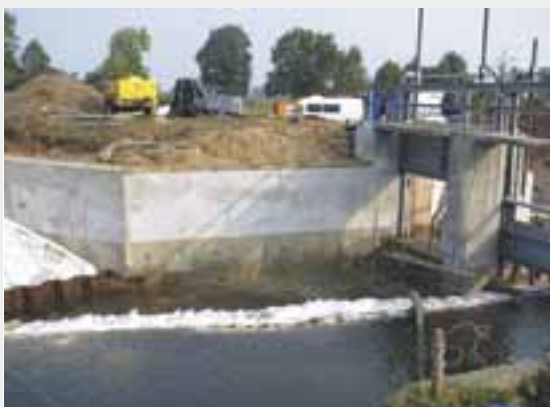
RENOWACJA JAZU MATERIAŁEM TOPOLIT® KANALSANIERMÖRTEL (KSM)
