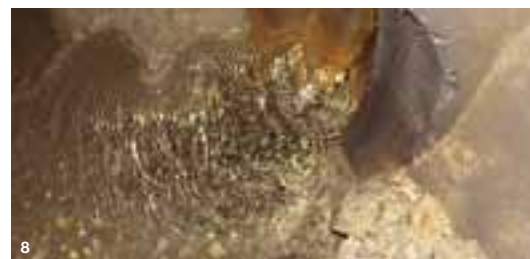
5. widok kanału | 6. urządzenie aplikujące materiał podczas pracy | 7. mała poręczna pompa natryskująca PFT | 8. substancje obce zawarte w ściekach powodujące abrazje
