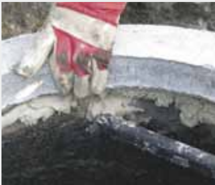
PODNIĘCIE RAMY WŁAZU ZA POMOCĄ KREGU BETONOWEGO OSADZONEGO NA ZAPRAWIE TOPOLIT® FIX PLAST
