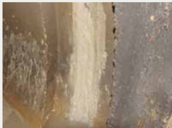
PRZECIEK ZATAMOWANY PRZY UŻYCIU TAMPONAŻOWEJ ZAPRAWY TOPOLIT® WASSERSTOP 0,5
