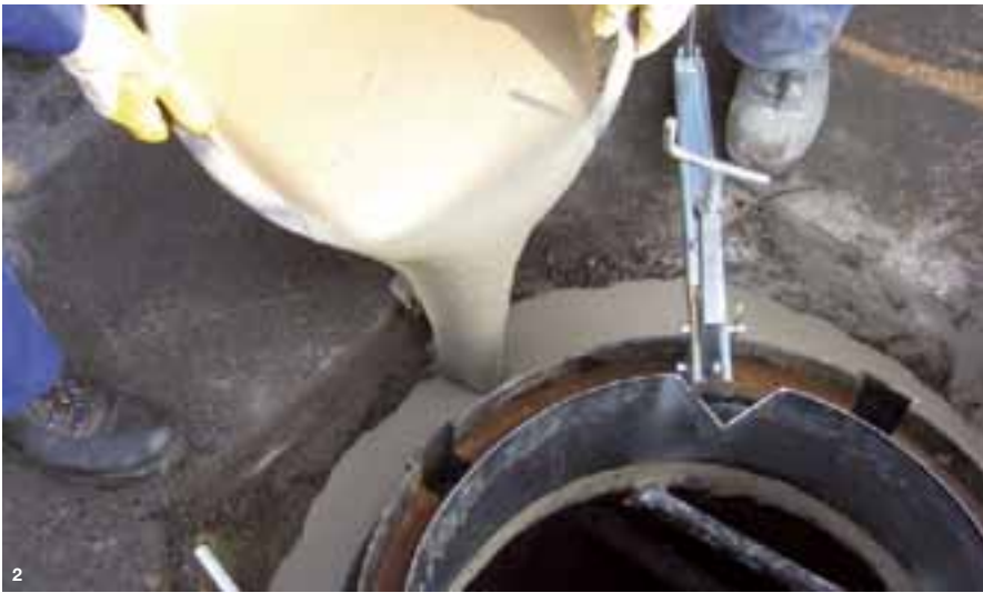
1. roboty wykończeniowe włazu do studzienki | 2. zalewanie z zastosowaniem szalunku blaszanego | 3. urządzenie do wycinania i podnoszenia ramy włazu | 4. szalunek gumowy
