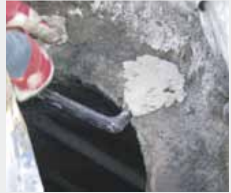
ZAKOTWIENIE STOPNIA ZA POMOCĄ ZAPRAWY TOPOLIT® STOPFZEMENT 1
