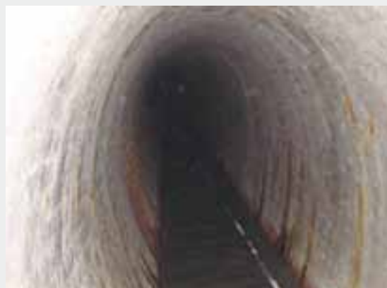
NAPRAWA I OCHRONA CEGLANYCH KANAŁÓW PRZEŁAZOWYCH ZAPRAWĄ TOPOLIT® KANALSANIERMÖRTEL (KSM)
