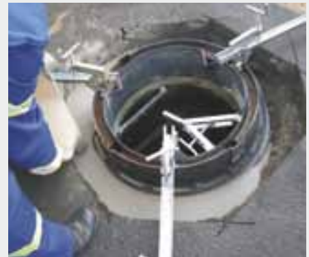
ZAKOTWIENIE RAMY WŁAZU ZA POMOCĄ SZYBKOWIĄŻĄCEJ ZAPRAWY TOPOLIT® FIX
