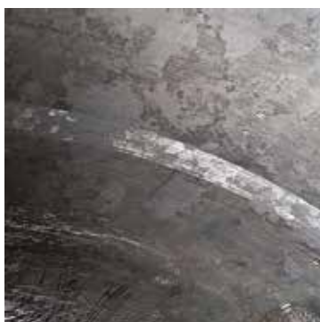
Rura po czyszczeniu
