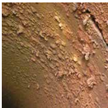
Rura przed czyszczeniem
