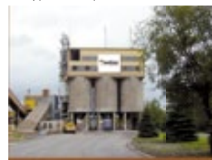
8. Silosy na kruszywo
