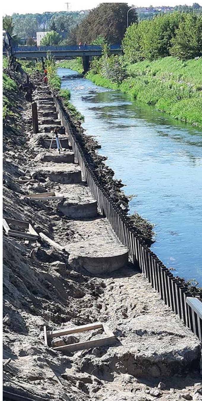
PARNU, ESTONIA: REALIZACJA PRZESŁONY FILTRACYJNEJ PRZY WYSYPISKU ODPADÓW CHEMICZNYCH PO PRZEMYSŁE GARBARSKIM.
