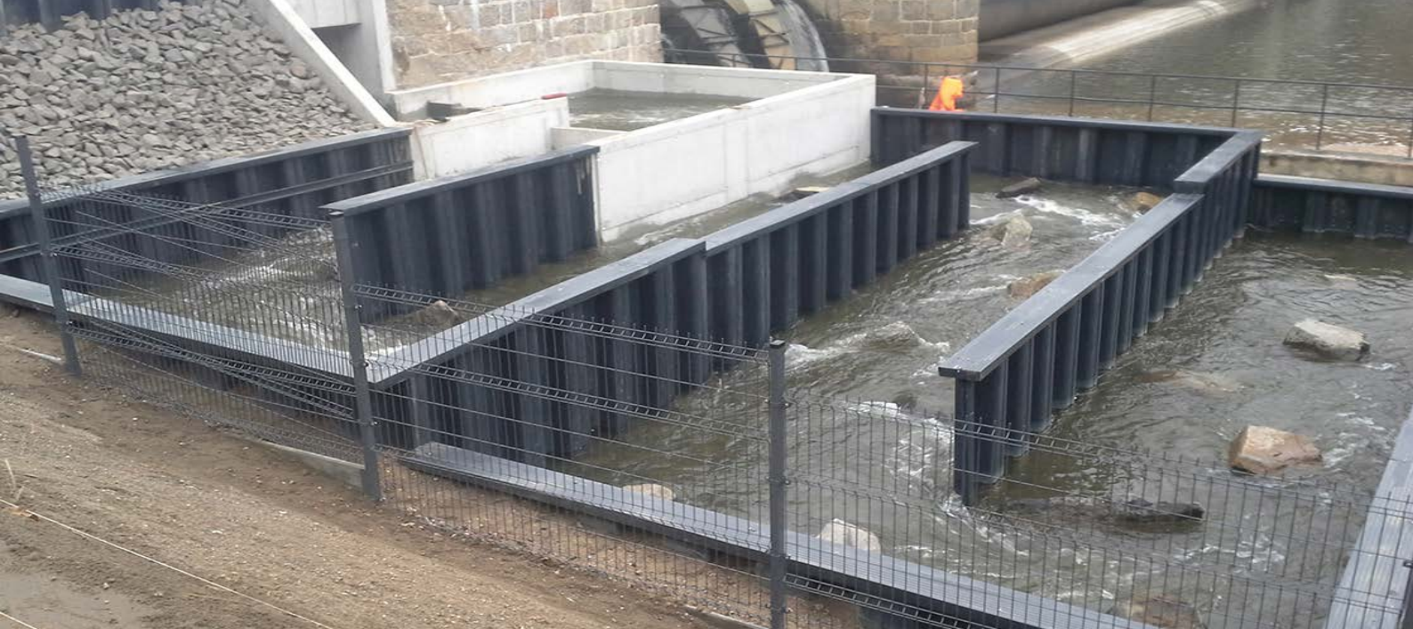
ŻAGAŃ, POLSKA: PRZEŁAWKA DLA RYB WYKONANA Z GRODZIC WINYLOWYCH WYPOSAŻONYCH W OCZEP.
