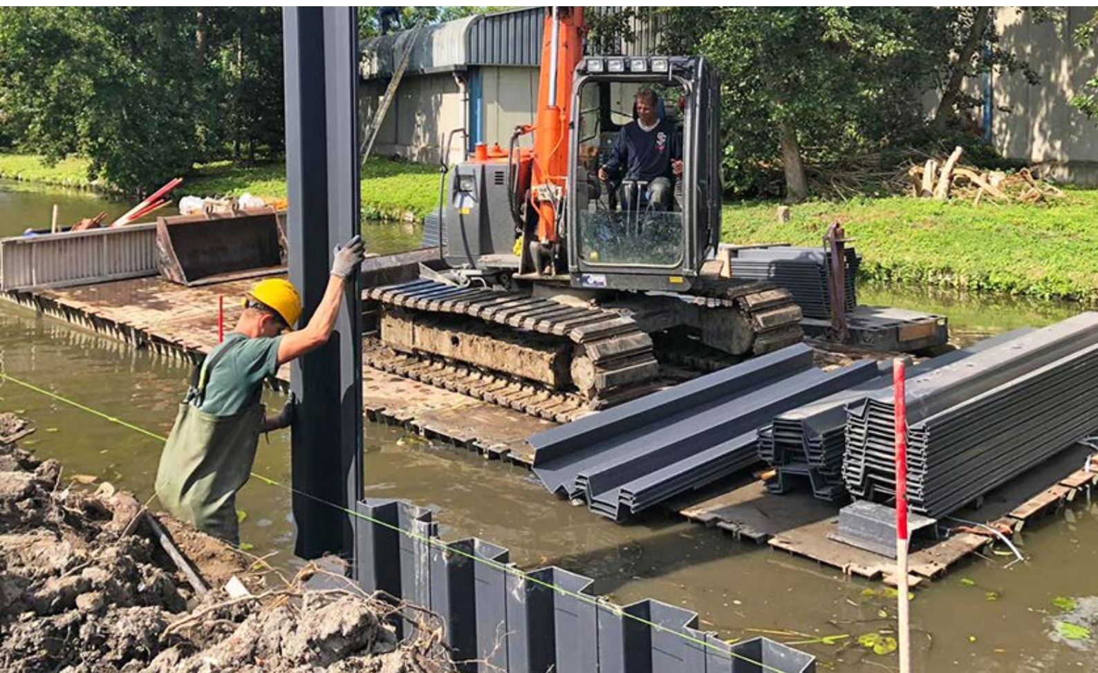
DELFT, HOLANDIA: ZABEZPIECZENIE BRZEGÓW KANAŁU.
