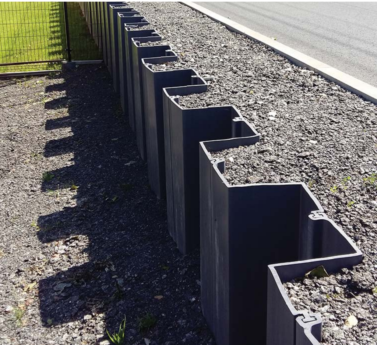
MARKŁOWICE, POLSKA: ŚCIANA OPOROWA TWORZĄCA KONSTRUKCJĘ DROGI.
