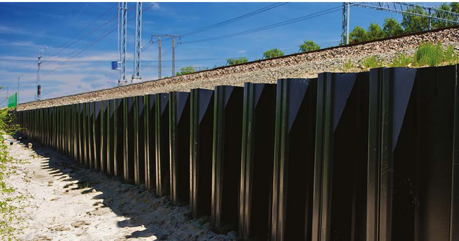
PRUSZKÓW, POLSKA: STABILIZACJA SKARPY NASYPU KOLEJOWEGO.
