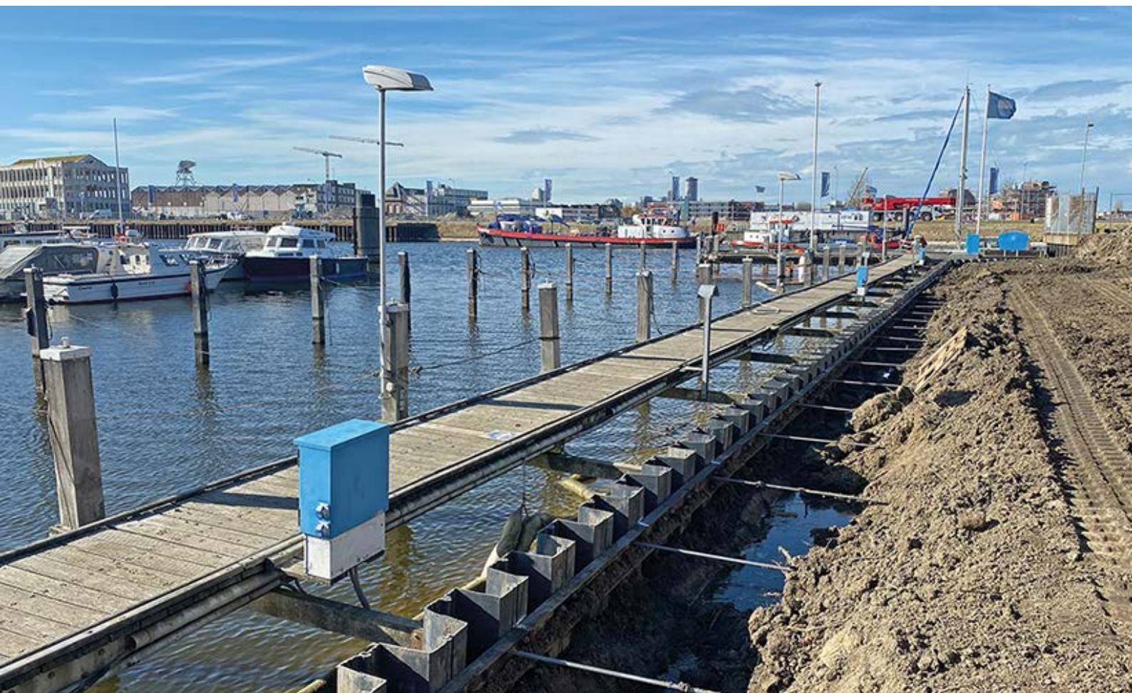
VLISSINGEN, HOLANDIA: KONSTRUKCJA Z GRODZIC WINYLOWYCH WZMOCNIONA SYSTEMEM KOTEW W PROJEKCIE MODERNIZACJI PORTU.
