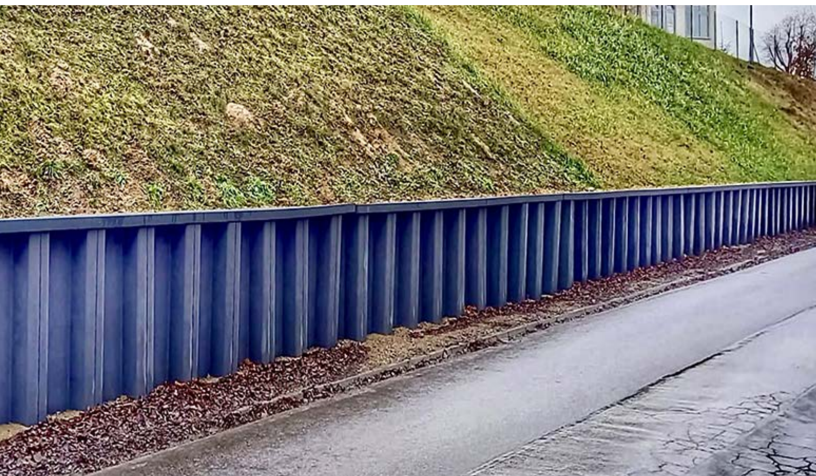
OKOLICE KRAKOWA, POLSKA: STABILIZACJA SKARPY PRZY DRODZE KRAJOWEJ.
