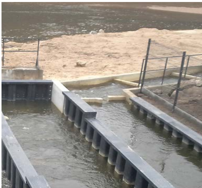
ŻAGAŃ, POLSKA: PRZEŁAWKA DLA RYB WYKONANA Z GRODZIC WINYLOWYCH WYPOSAŻONYCH W OCZEP.
