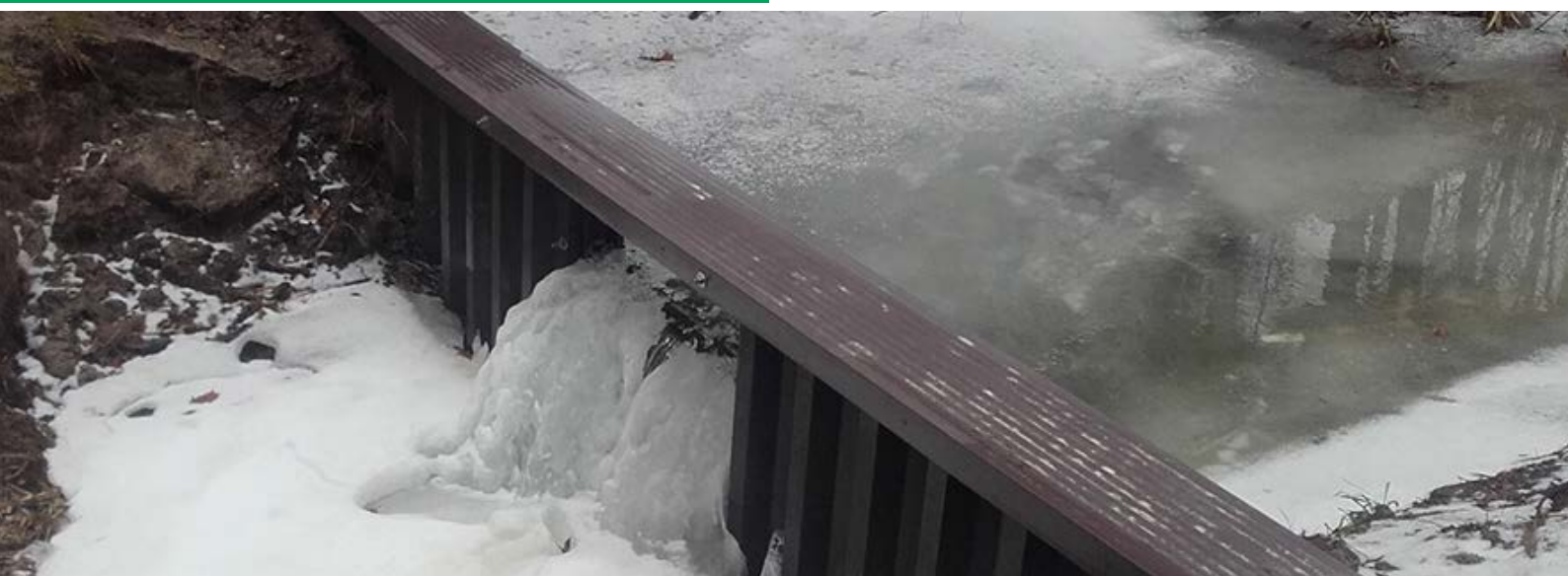
NADLEŚNICTWO PODANIN, POLSKA: ZASTAWKI WYKONANE Z PVC SĄ TRWAŁE I ODPORNE NA WARUNKI ATMOSFERYCZNE.
