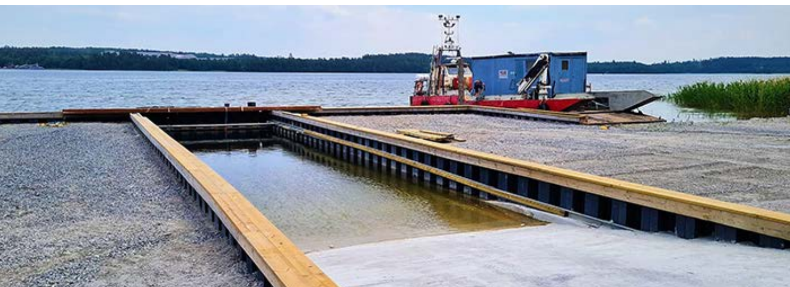
UPPSALA, SZWECJA: GRODZICE HYBRYDOWE SUPERLOCK WYKORZYSTANE DO BUDOWY RAMPY DO WODOWANIA ŁODZI.
