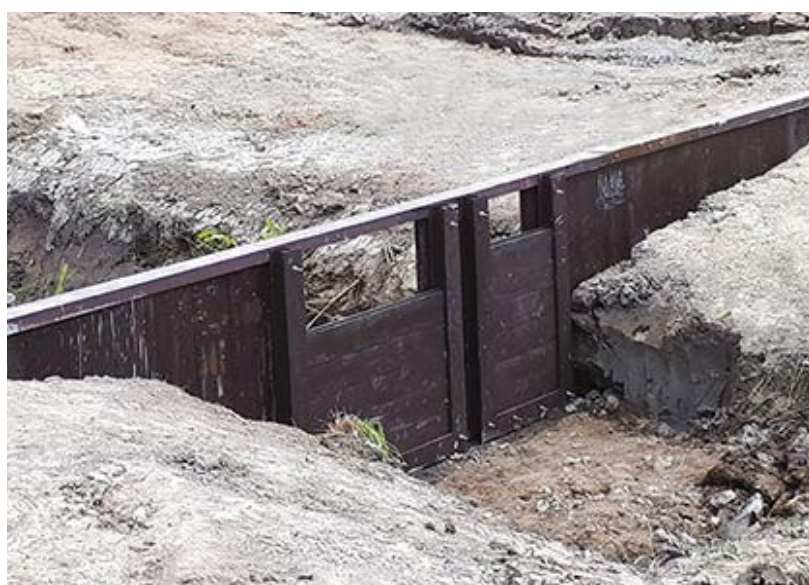
SZWECJA: PIERWSZA WINYLOWA ZASTAWKA MAŁEJ RETENCJI ZAINSTALOWANA POZA GRANICAMI POLSKI.
