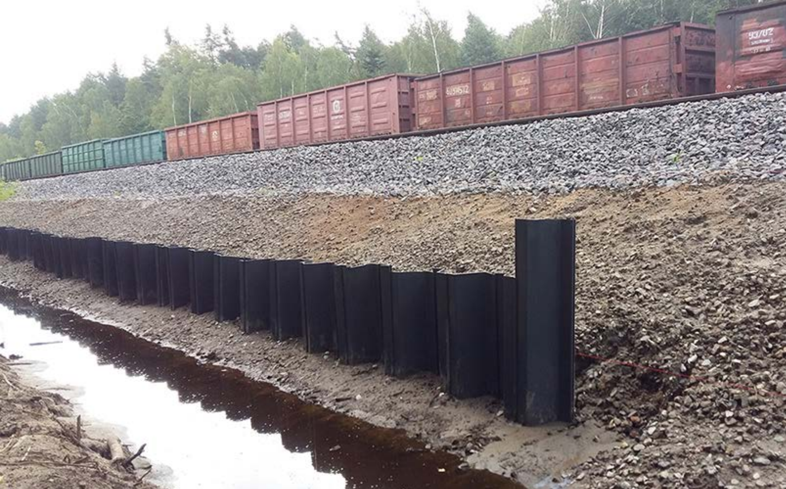
STALOWA WOLA, POLSKA: STABILIZACJA NASYPU KOLEJOWEGO.
