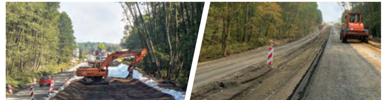
Zachowanie ciągłości ruchu / Remont połówkowy w dwóch niezależnych etapach
