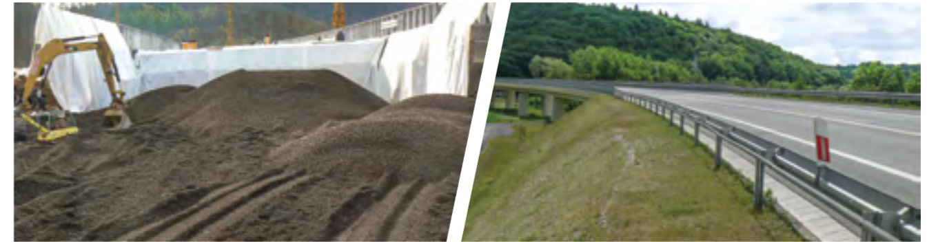
Najazd na wiadukt
