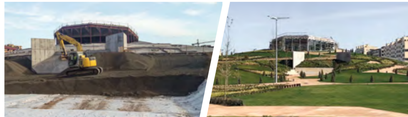
Leca® KERAMZYT umożliwił realizację śmiałego projektu zagospodarowania terenu nad podziemnym dworcem kolejowym
