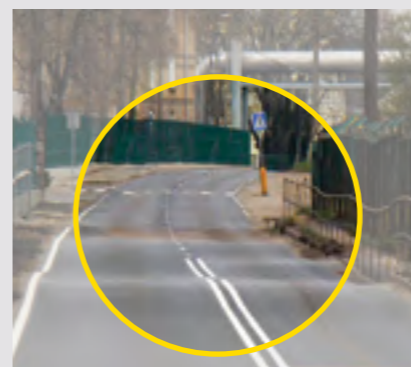
Deformacja nawierzchni
